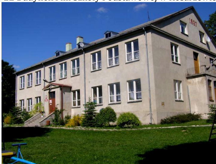
Zdjęcie 12 Budynek Filii Szkoły Podstawowej w Kosarzewie Dolnym
